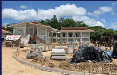
Campus Nicoya (Obra en proceso de construcción)
